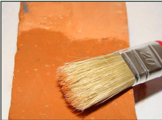
Påfør primer og la den tørke
